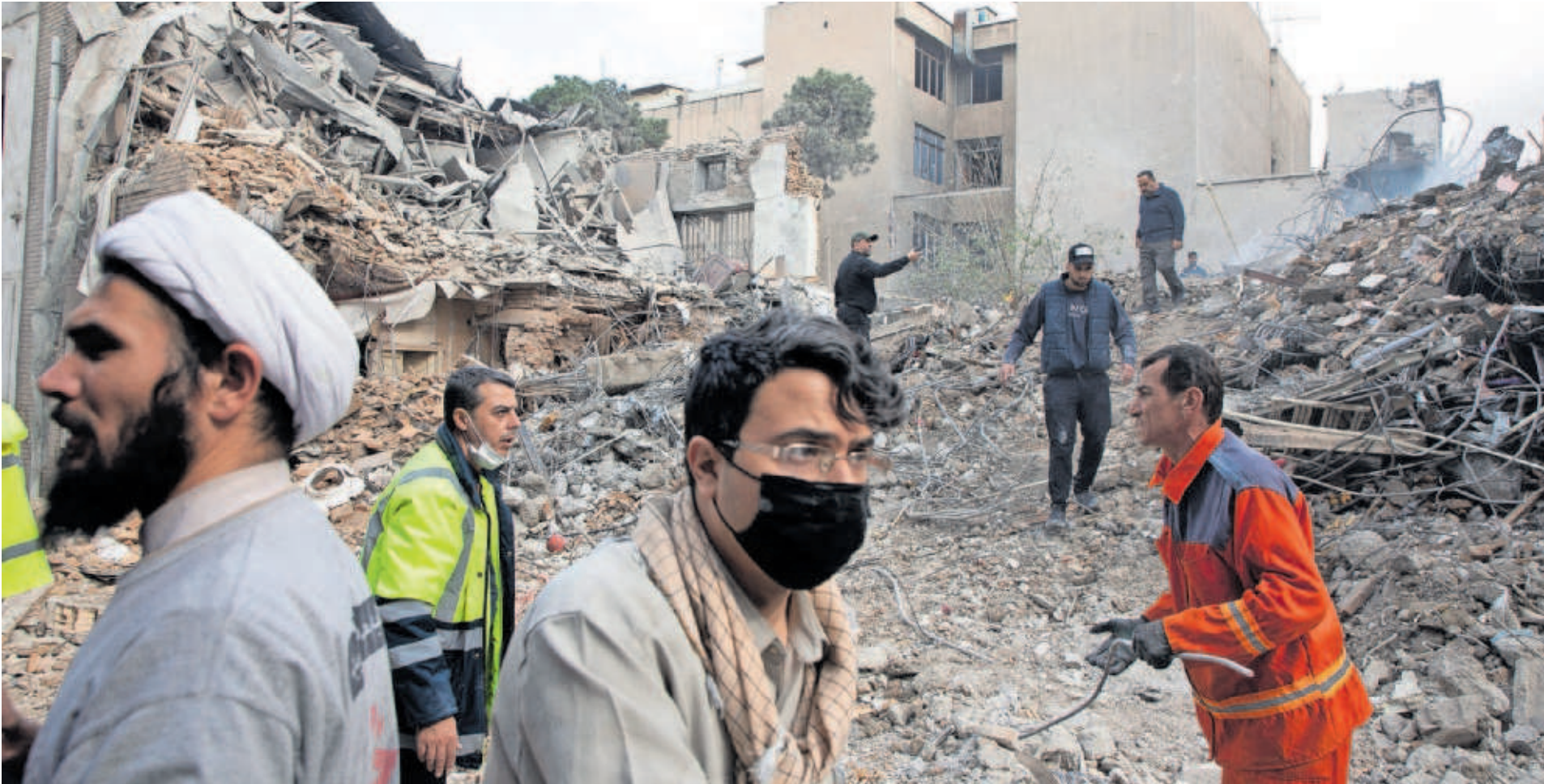
Equipos de emergencia trabajaban ayer en un edificio destruido en Teherán por un ataque de EE UU e Israel, que también alcanzó una sinagoga judía. MAJID SAEEDI (GETTY)
