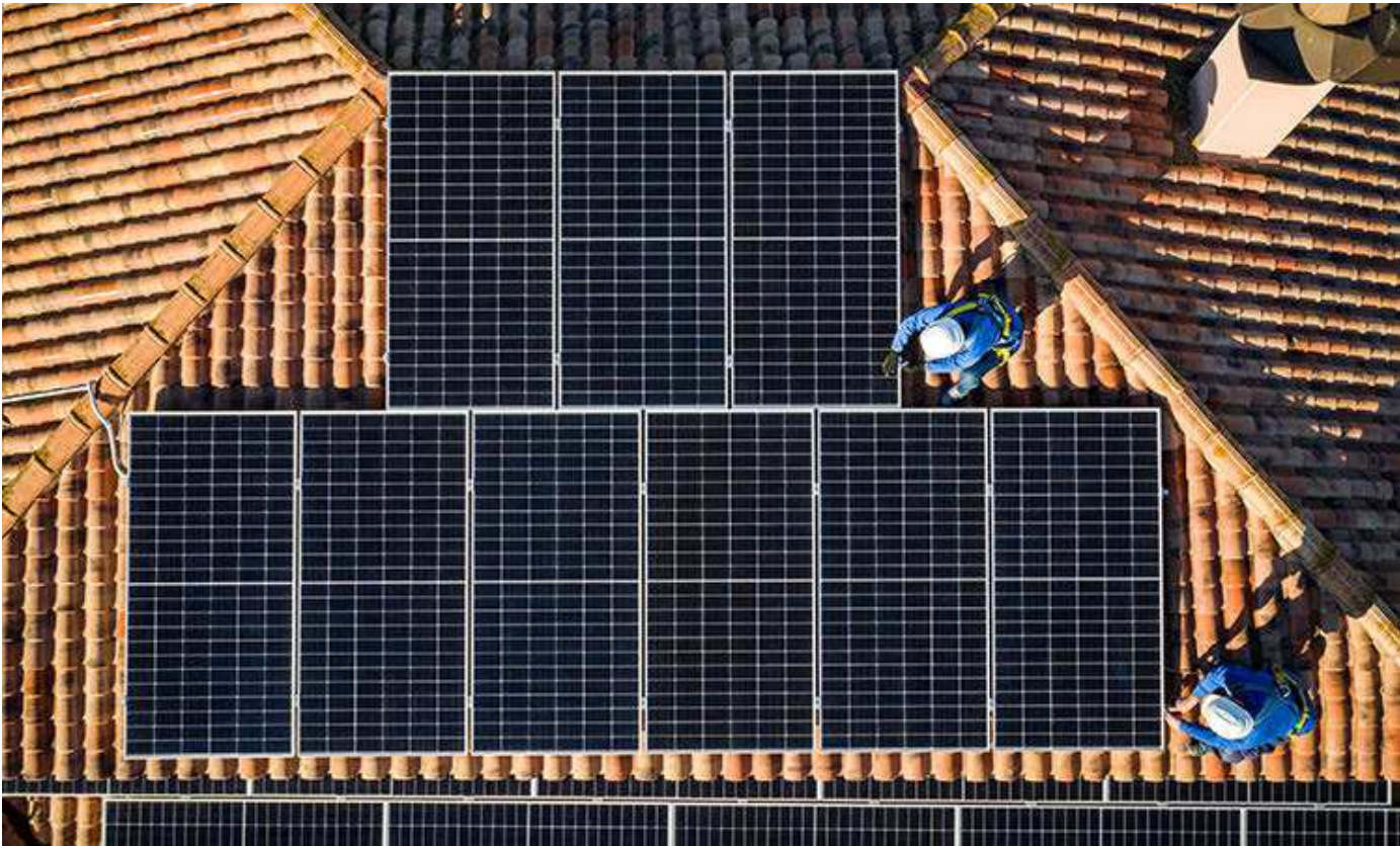
Vista aérea de dos instaladores colocando paneles solares en el tejado de una vivienda.
