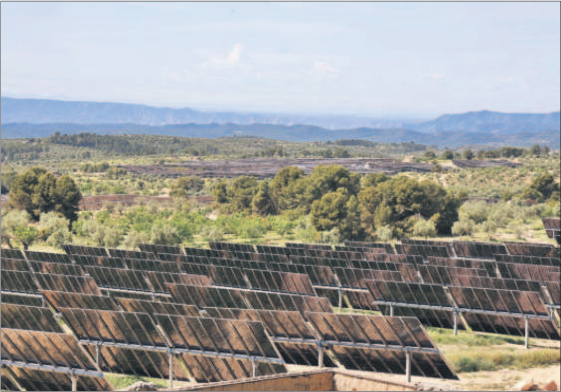
El grupo Engie, promotor de la central solar en obras de Auliver, entre Llardecans y la Granadella, quiere dotarla de baterías.
