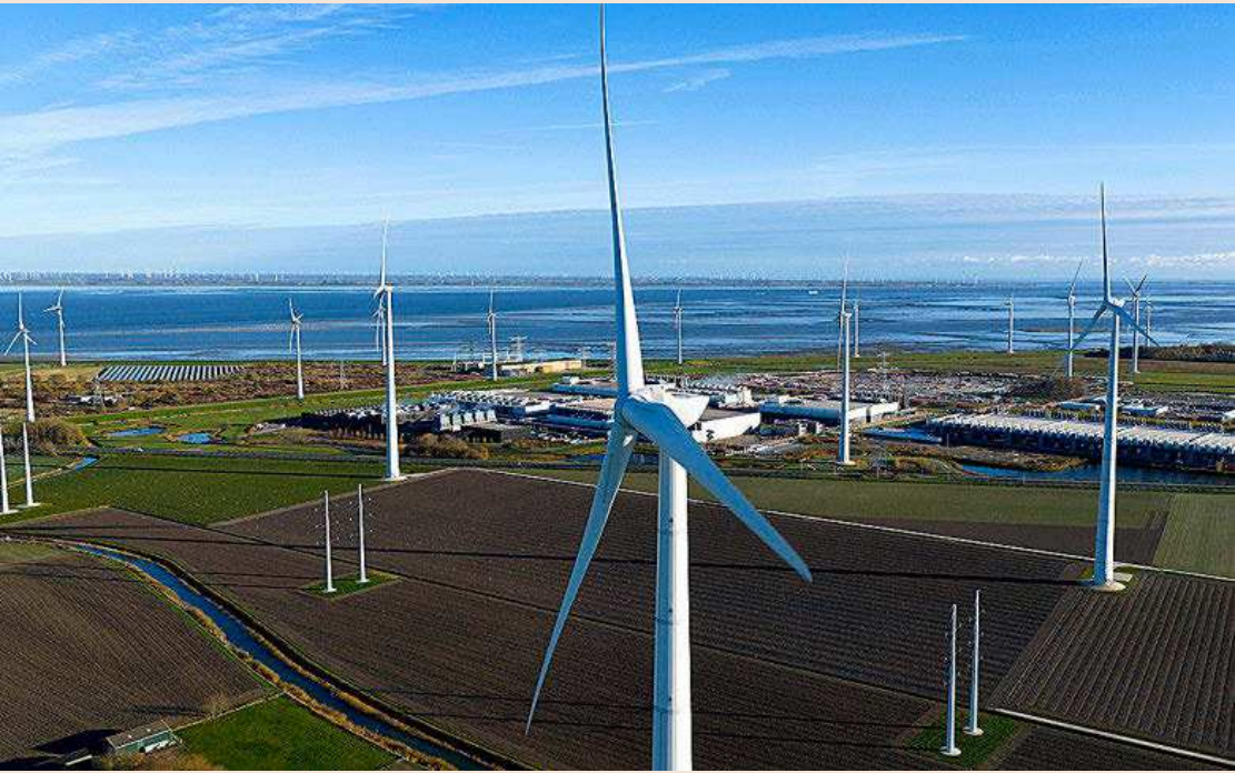
El proyecto de decreto de centros de datos prevé que haya generación renovable cerca de cada planta.
