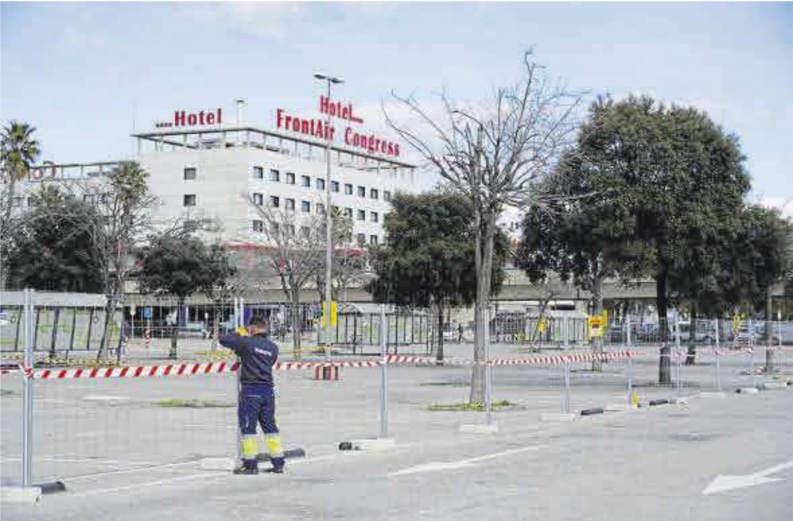
Obras para transformar el parking del Alcampo de Sant Boi en una planta fotovoltaica.
