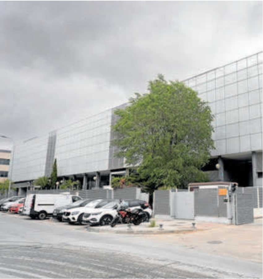
Centro de datos de Telvent en Alcobendas (Madrid). Matías Nieto
