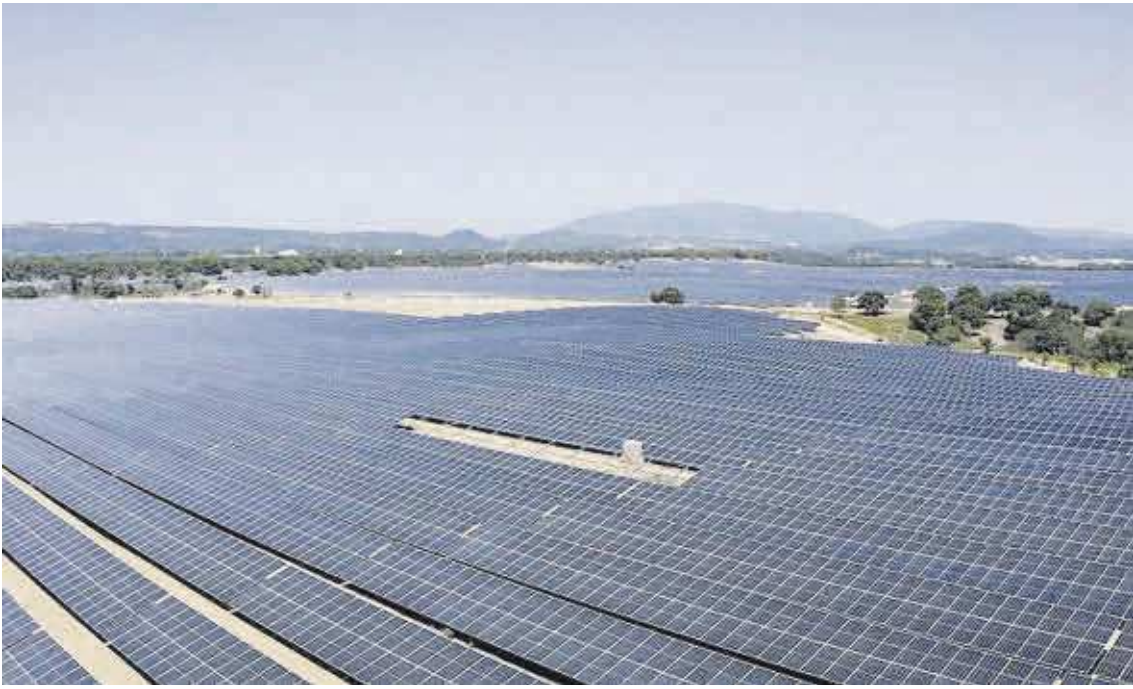
Miles de placas solares en una megaplanta fotovoltaica de Audax Renovables.
