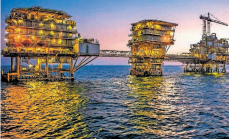
Instalaciones de Aramco en el golfo Pérsico. CORDON PRESS
