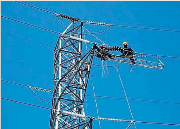
Operarios trabajando en una línea de alta tensión.
