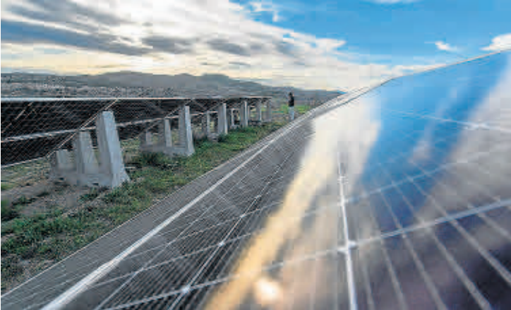
Instalación de paneles solares. ANTONIO GARCÍA / HERALDO
