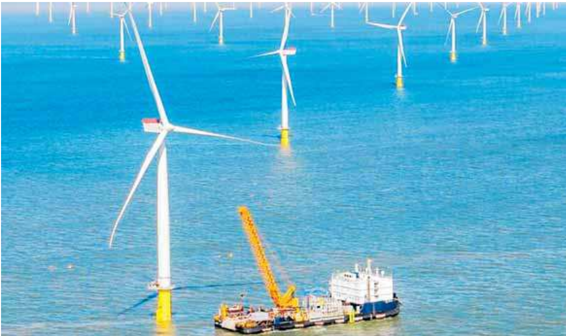
Imagen de un parque eólico marino instalado en el norte de Europa. c7
