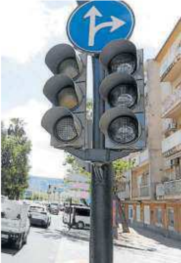
Un semáforo apagado. Foto: E.P.
