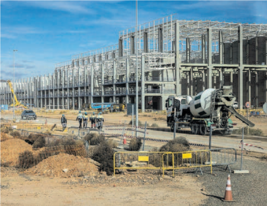
Obras en la de nueva gigafactoría de baterías de PowerCo en Sagunto. MÓNICA TORRES
