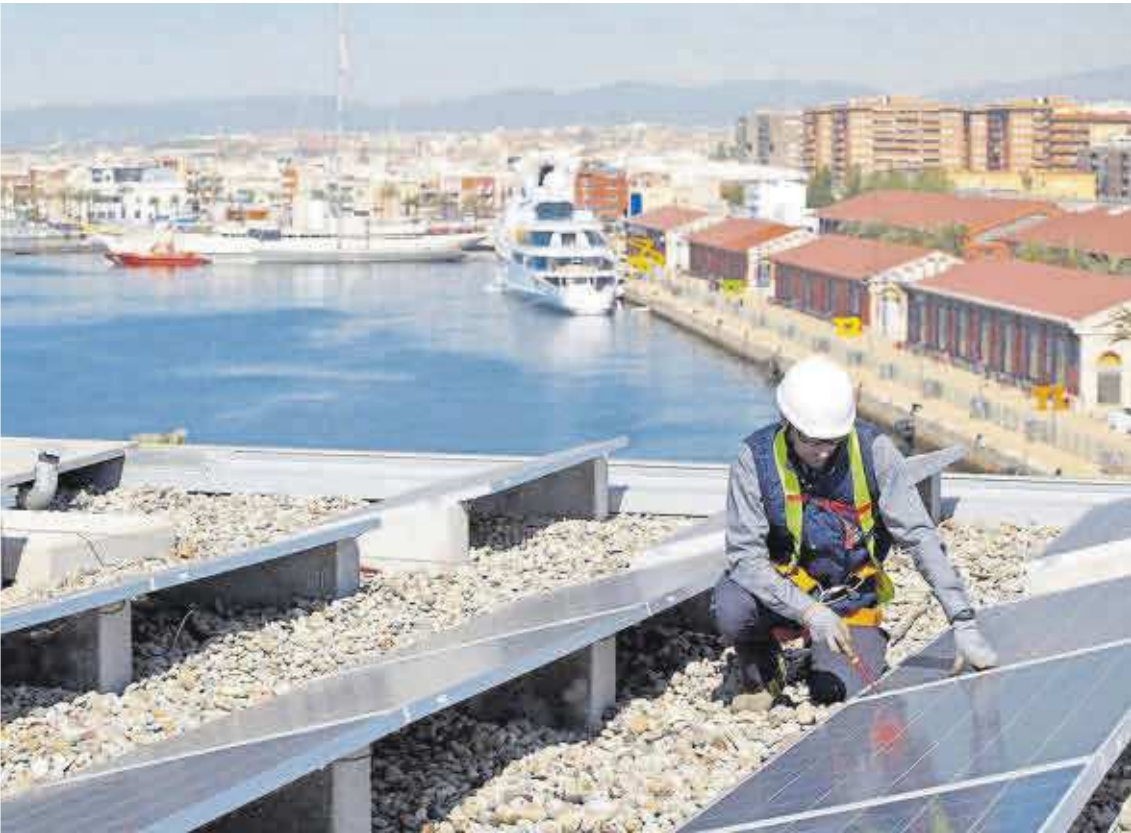
Un trabajador instala placas fotovoltaicas en el Port de Tarragona.
