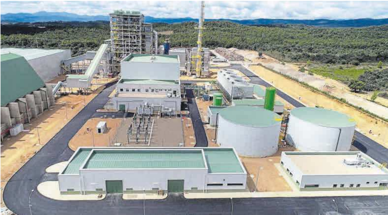
La planta de biomasa que Forestalia tiene en Cubillos de Sil (León), una de las mayores que hay en operación en España.
