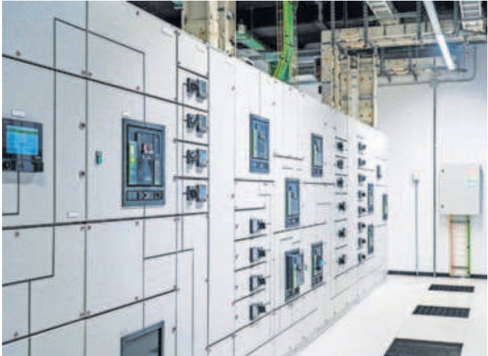
Transformadores de energía en Digital Reality, Madrid. I. ARCONES
