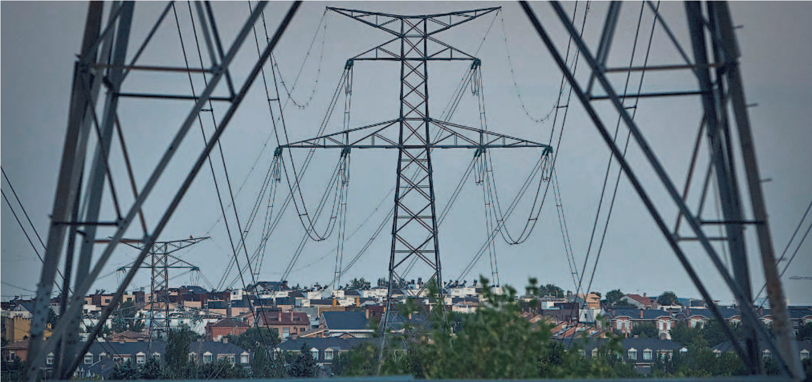
Un megavatio no pesa lo mismo según quién lo cargue. En España, desde hace años, lo cargan las casas. En la imagen, torres de alta tensión en Madrid
