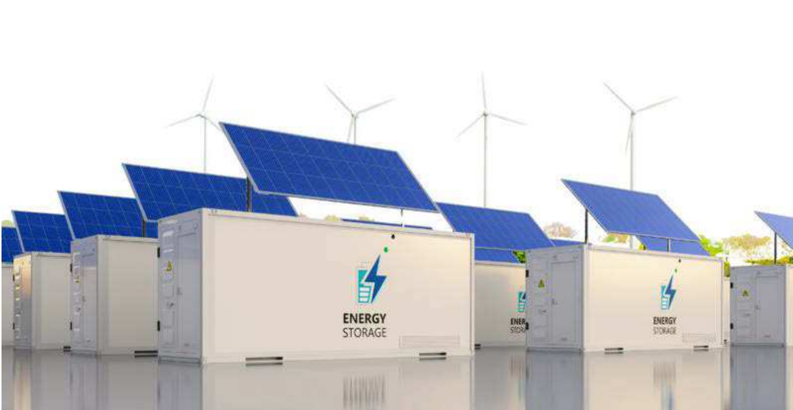
Una imagen de baterías, sistema de almacenamiento de energías renovables que se analiza en una nueva entrega del podcast ‘Futuro Verde’. /CEDIDA
