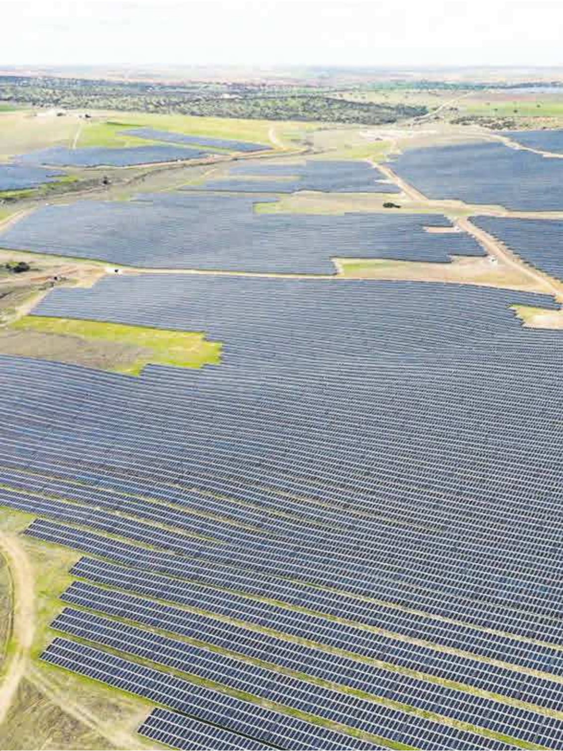
Vista aérea de un parque fotovoltaico en Badajoz.
