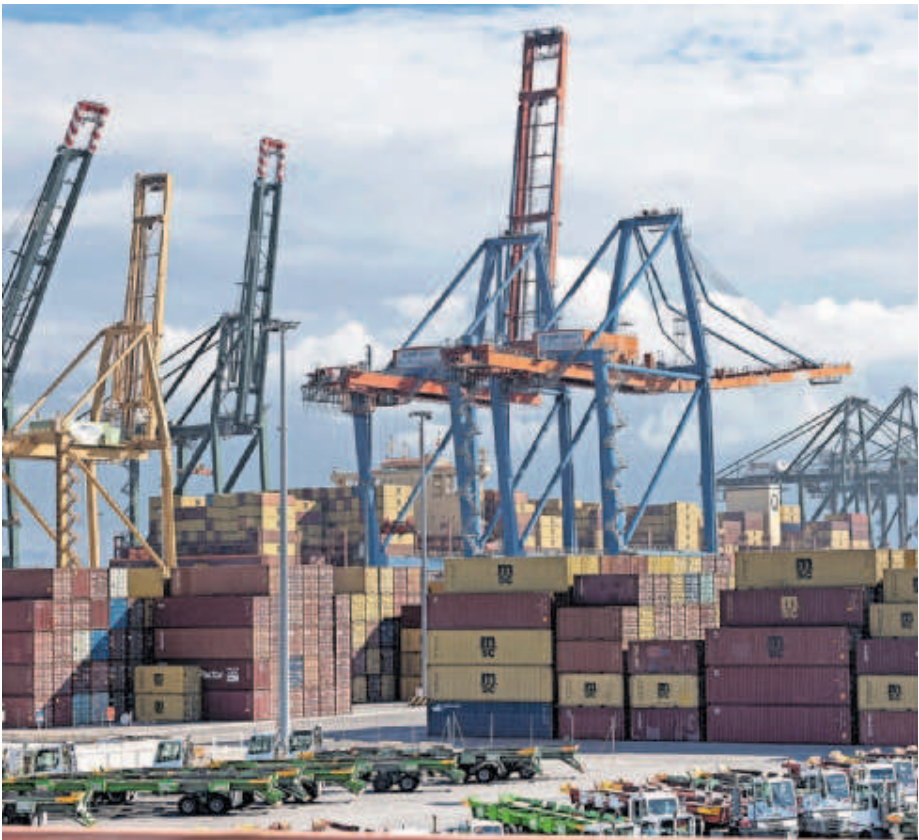
Grúas y contenedores en el puerto de Valencia. MÓNICA TORRES
