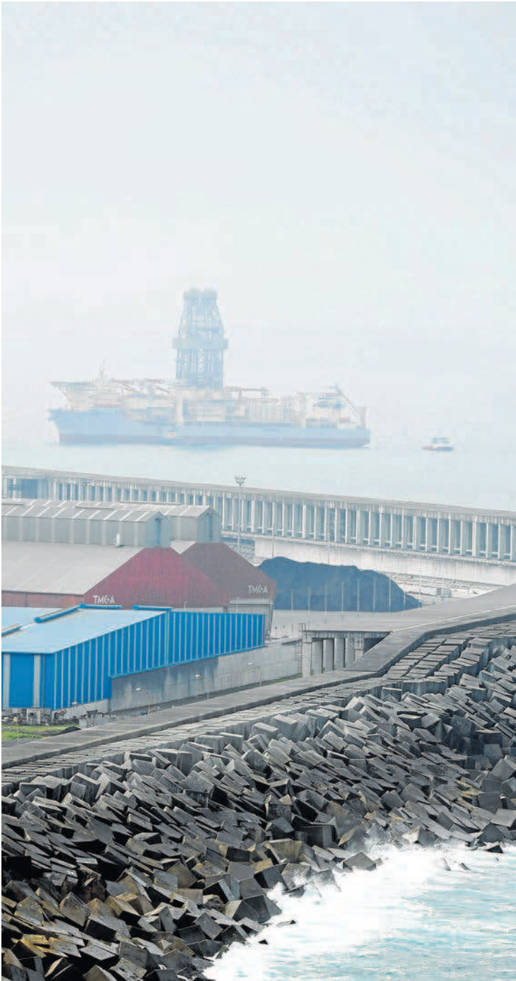
Puerto Exterior de A Coruña | GERMÁN BARREIROS
