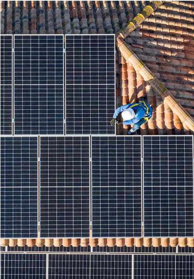
Operario instala placas solares en un tejado. iStock
