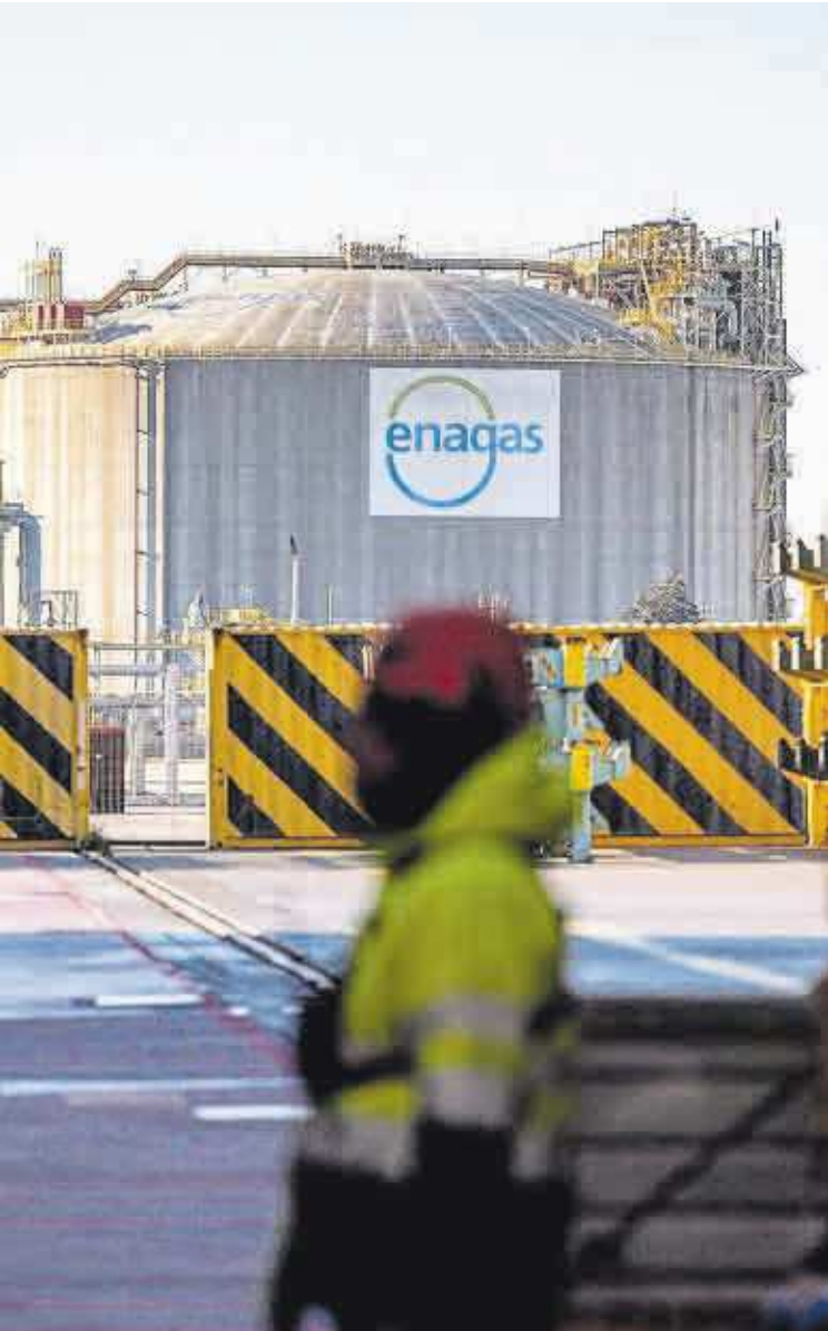
Tanque de almacenamiento de gas de Enagás en el Puerto de Barcelona.
