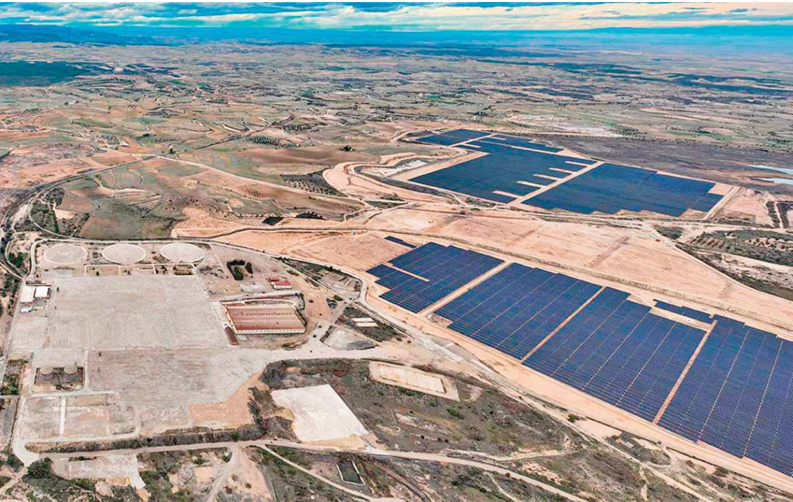
Proyectos solares Mudéjar y Sedeis V, ambos de Enel Green Power España y fuera del Nudo, cerca de la térmica. Endesa
