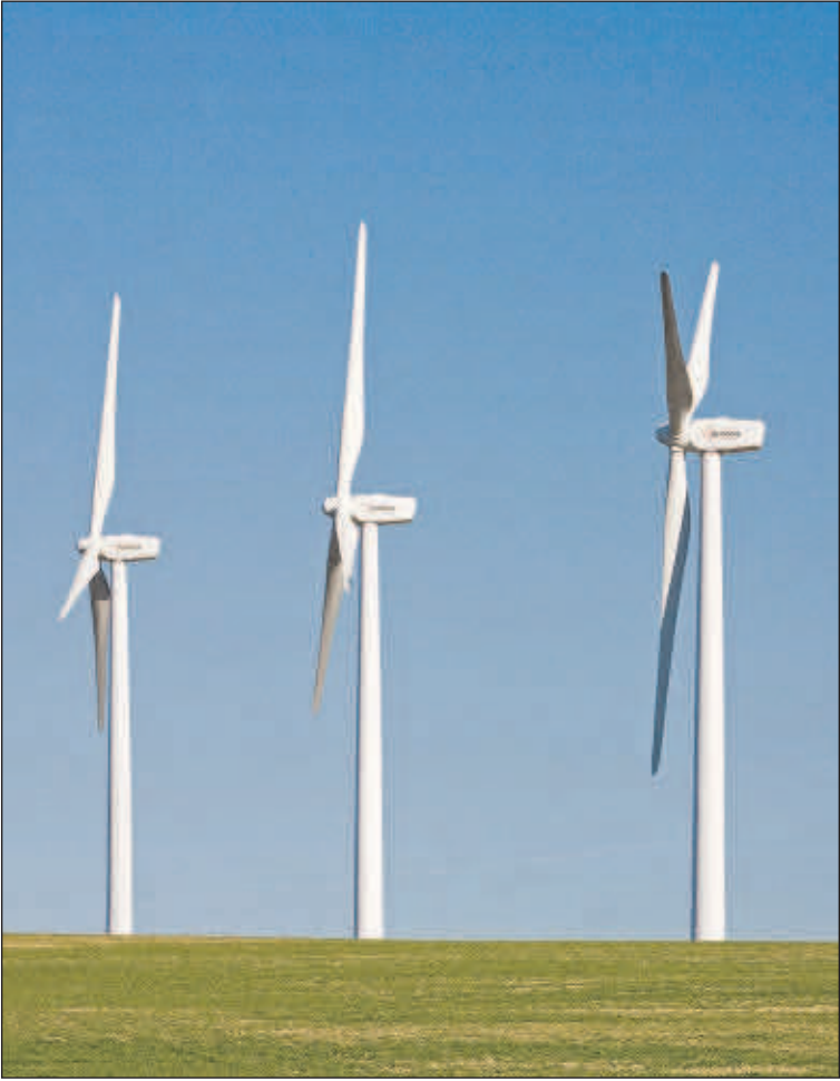
Aerogeneradores de Acciona. EE
