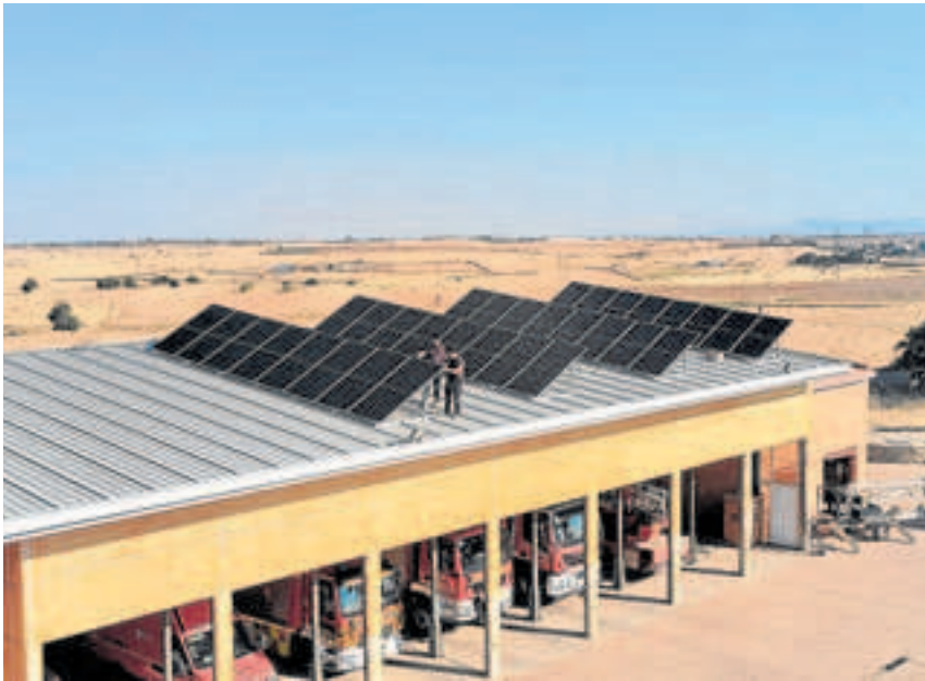
Instalación de paneles solares en el parque de Peñarroya. ABC
