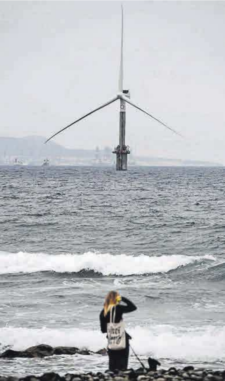
Aerogenerador flotante del Plocan en la costa de Gran Canaria.
