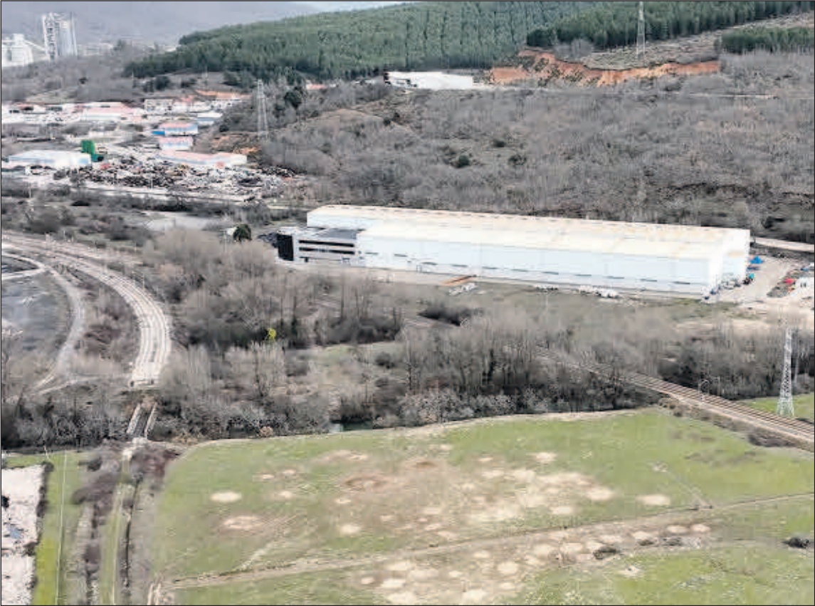
Vista aérea de la nave que ha adquirido Reolum. EE
