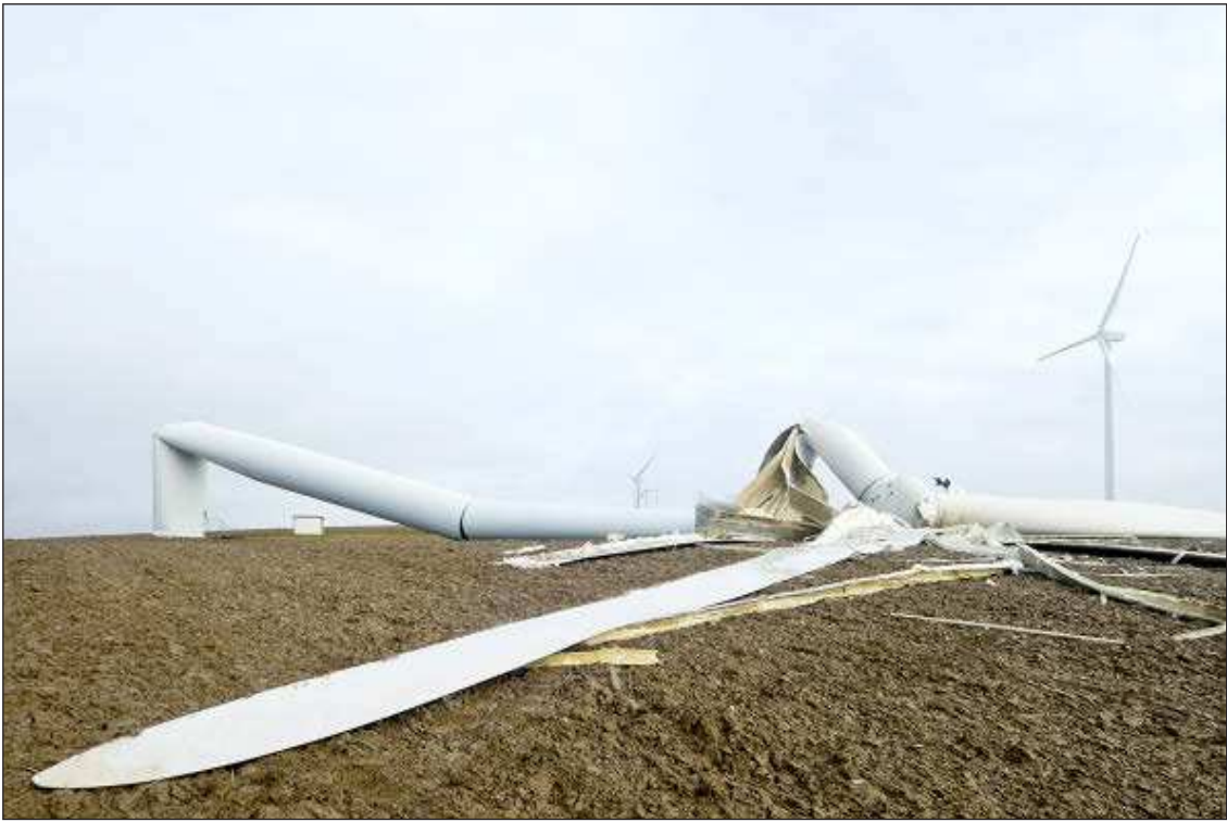
Un aerogenerador destrozado. ISTOCK
