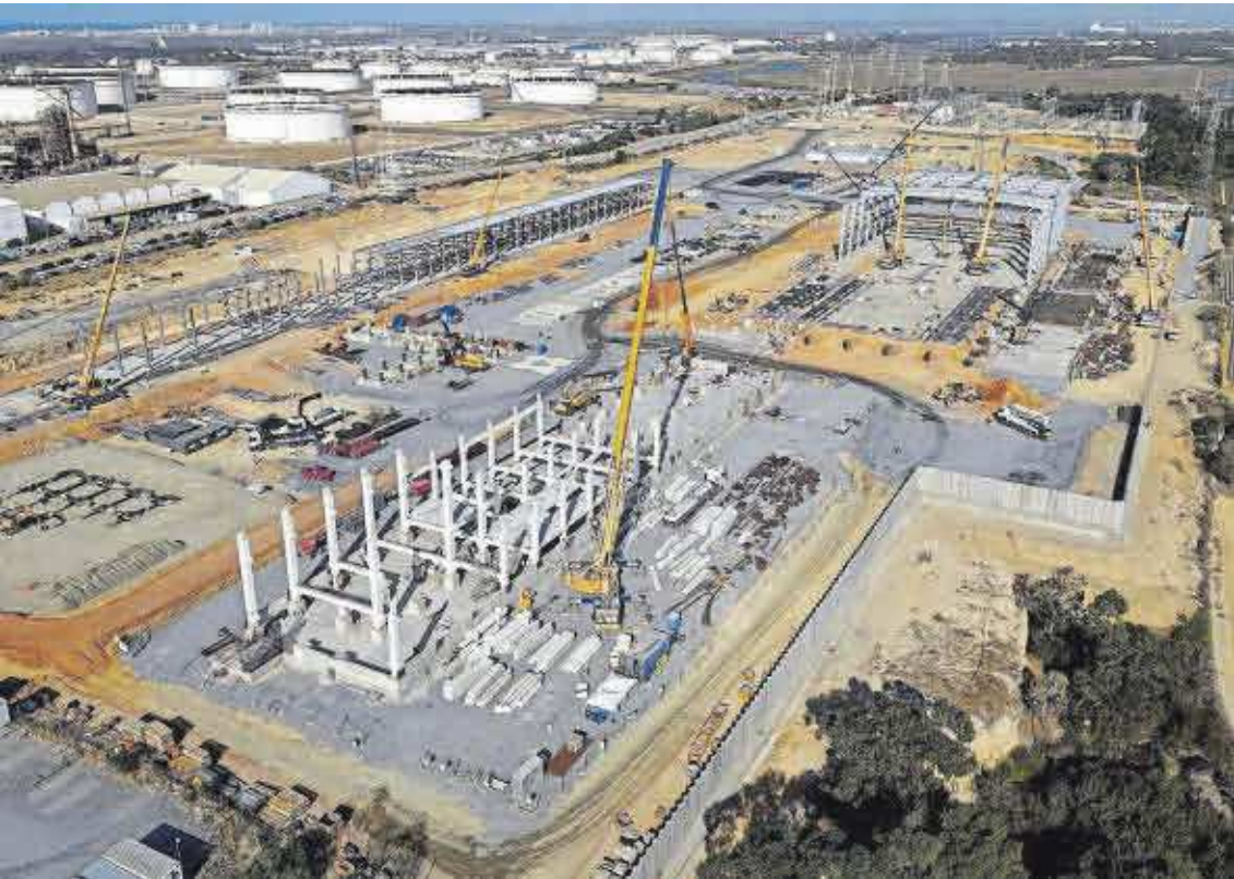
Construcción de la planta Onuba de Moeve en Palos de la Frontera (Huelva).
