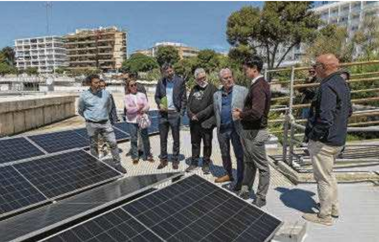
Visita institucional a la instalación fotovoltaica que se ha colocado en la cubierta del edificio Playamero. FOTO: AJ. SALOU
