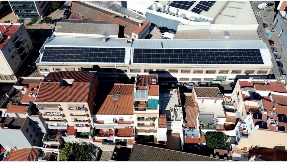
Primer proyecto GURB de Som Energia: instalación solar de 750 metros cuadrados sobre la cubierta de un edificio del barrio del Escorxador (Mataró). La cubierta fotovoltaica, de cien kilovatios de potencia (100 kW), genera electricidad que se reparte entre las personas y entidades de la cooperativa que están dentro de un radio de 2 kilómetros y tienen un contrato de electricidad con la cooperativa (Som es también comercializadora de electricidad). A ese primer GURB de Som Energia se han asociado más de 120 viviendas
