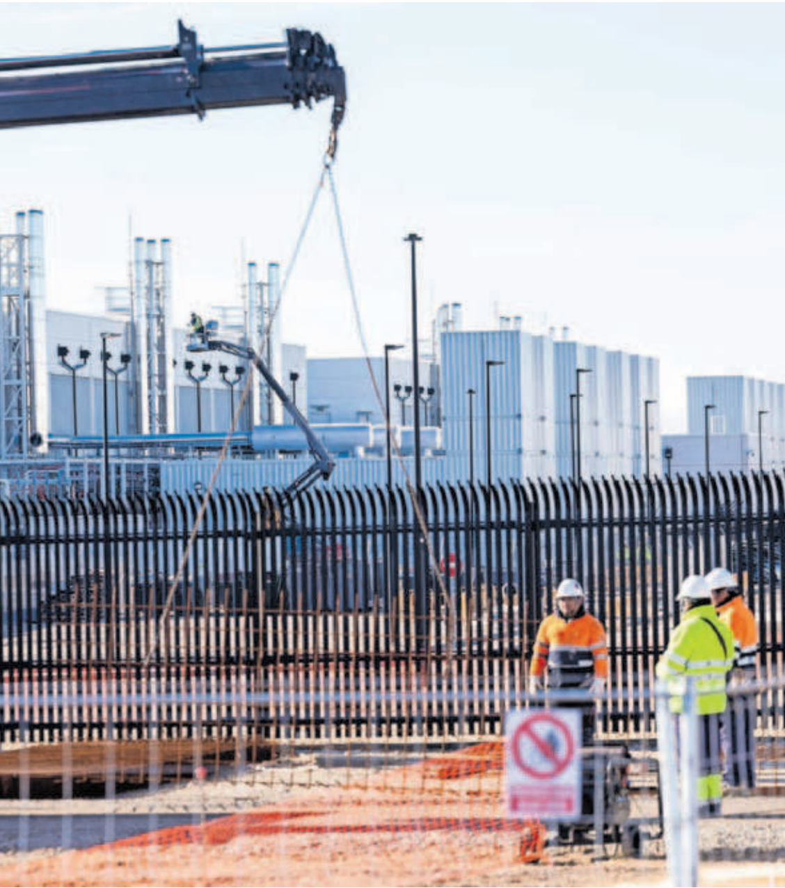
Construcción del centro de Amazon en Villanueva del Gállego, Zaragoza, el 22 de enero. CARLOS ROSILLO
