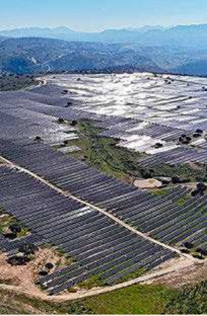
Imagen de una de las plantas solares ejecutadas por Aldesa.
