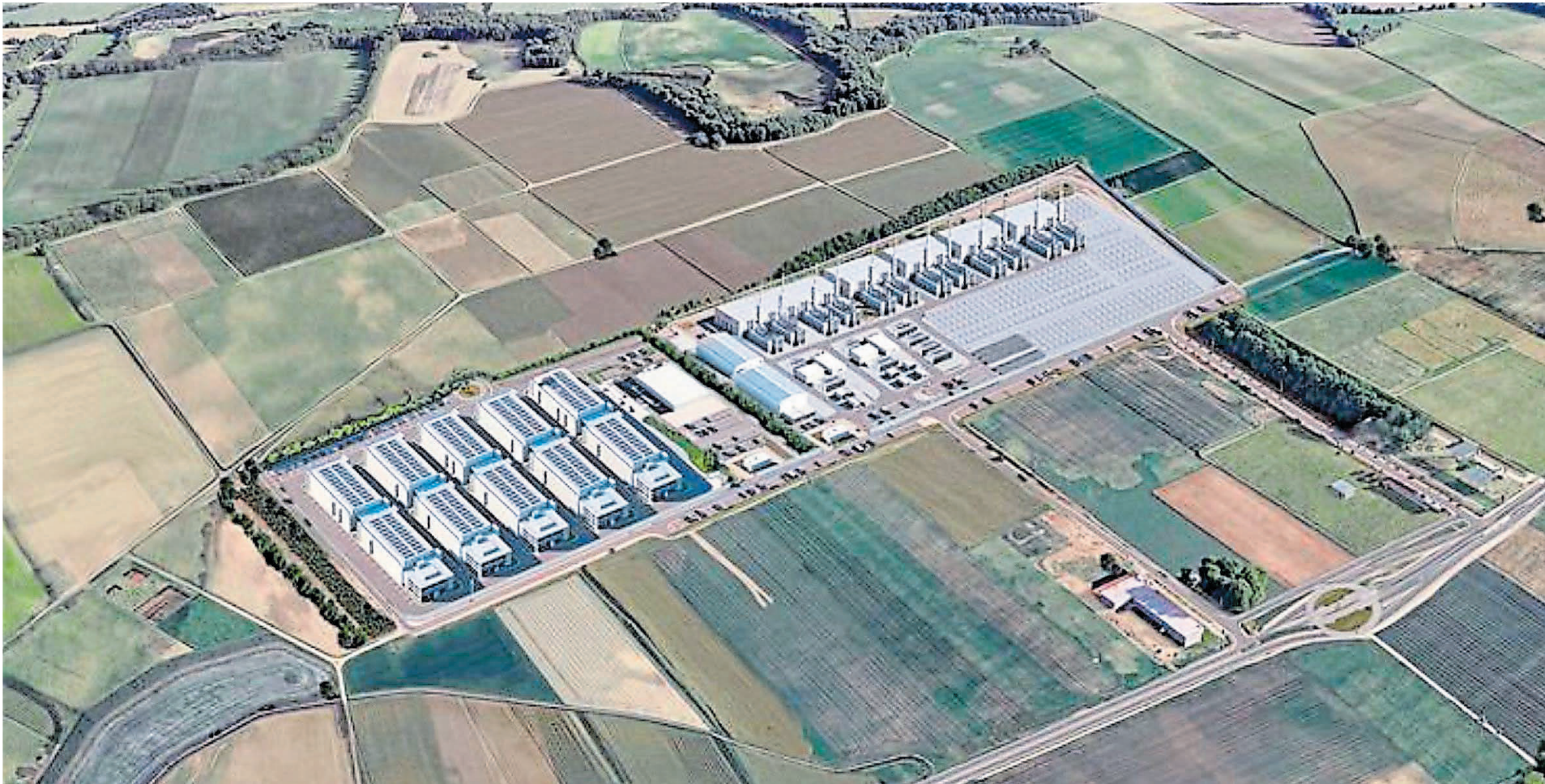
Centro de datos proyectado en Monfarracinos para el que se utilizará la energía de la planta fotovoltaica.
