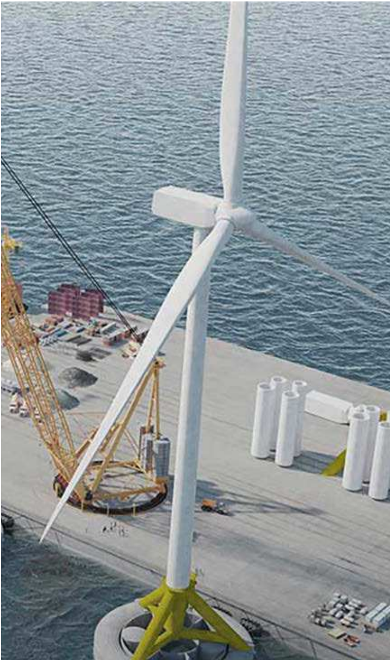
El montaje del aerogenerador flotante.
