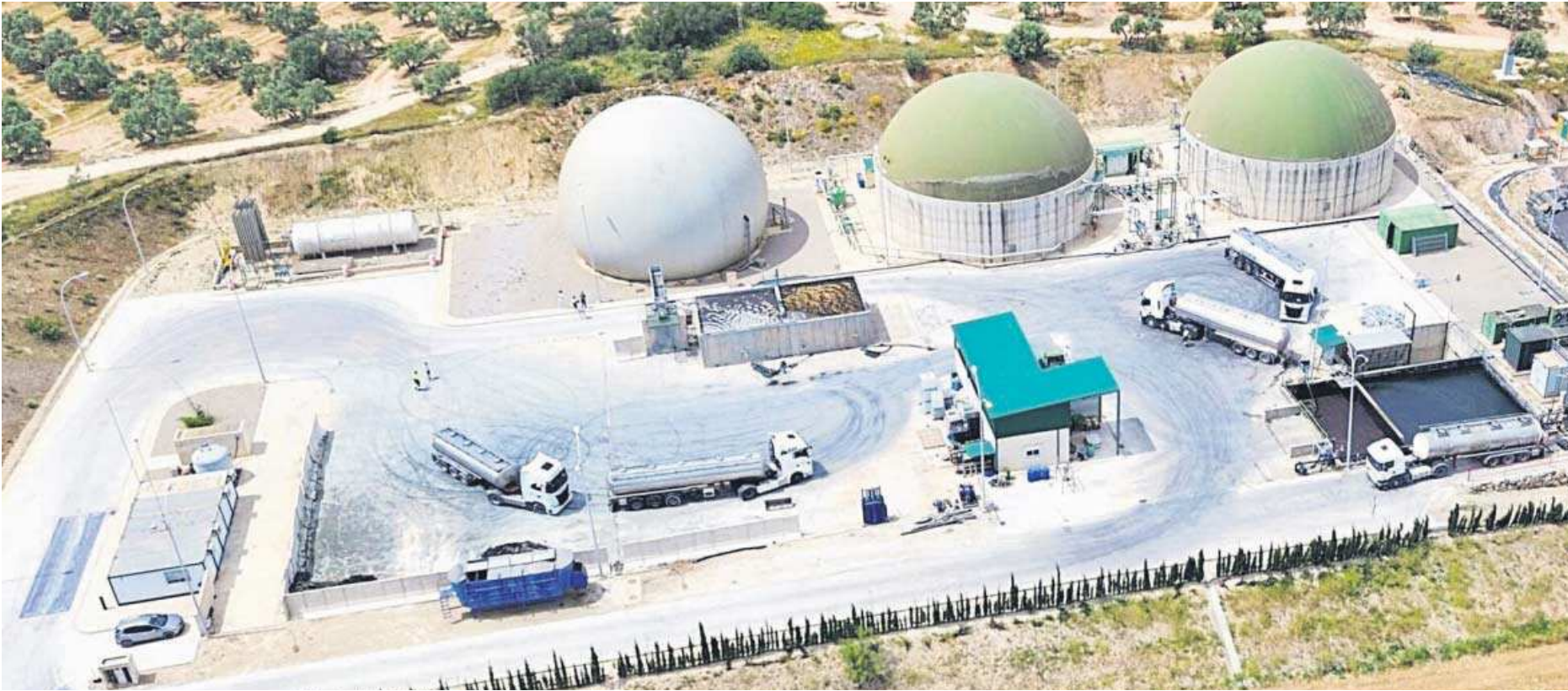
Vista de la planta de biogás de Campillos, en funcionamiento desde 2016.
