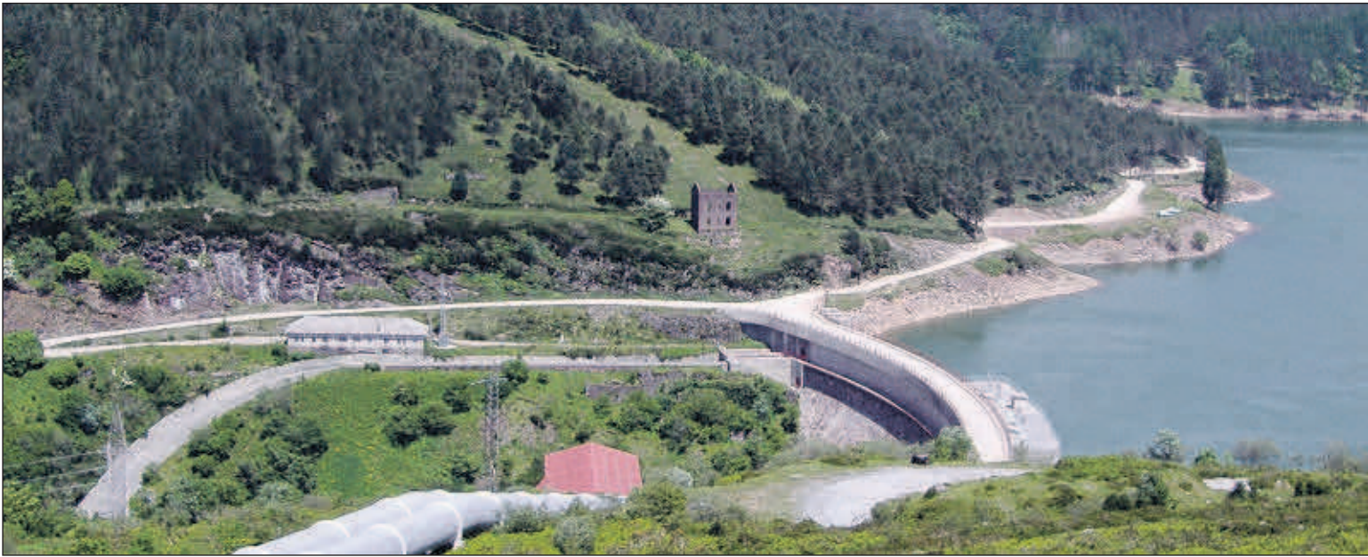
La central hidroeléctrica de Aguayo 1 en Cantabria. EE
