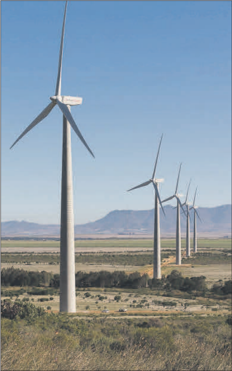
Instalaciones eólicas de Acciona. FIRMA
