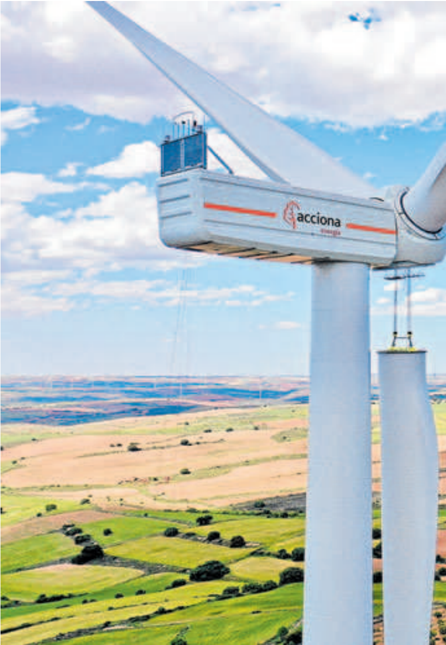
En el parque eólico Los Pedregales (Teruel), Nabrawind validó con éxito su solución para manipular palas sin utilizar grandes grúas.
