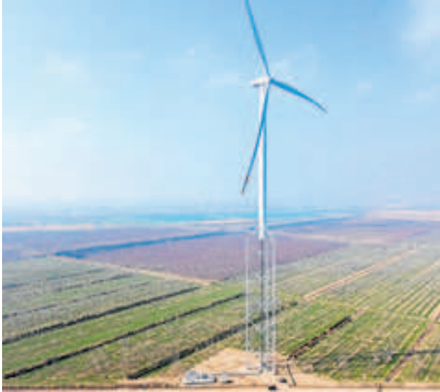
Montaje de una torre con la tecnología de Nabrawind.
