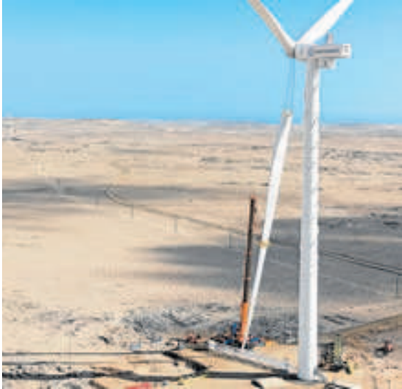
El sistema de Nabrawind para elevar las aspas.
