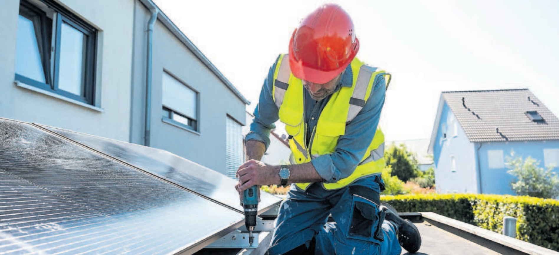
Un técnico instala una planta de autoconsumo solar en una vivienda. GETTYIMAGES
