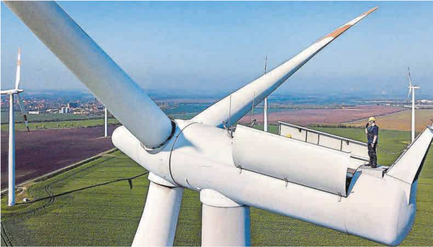
Turbina de energía eólica.
