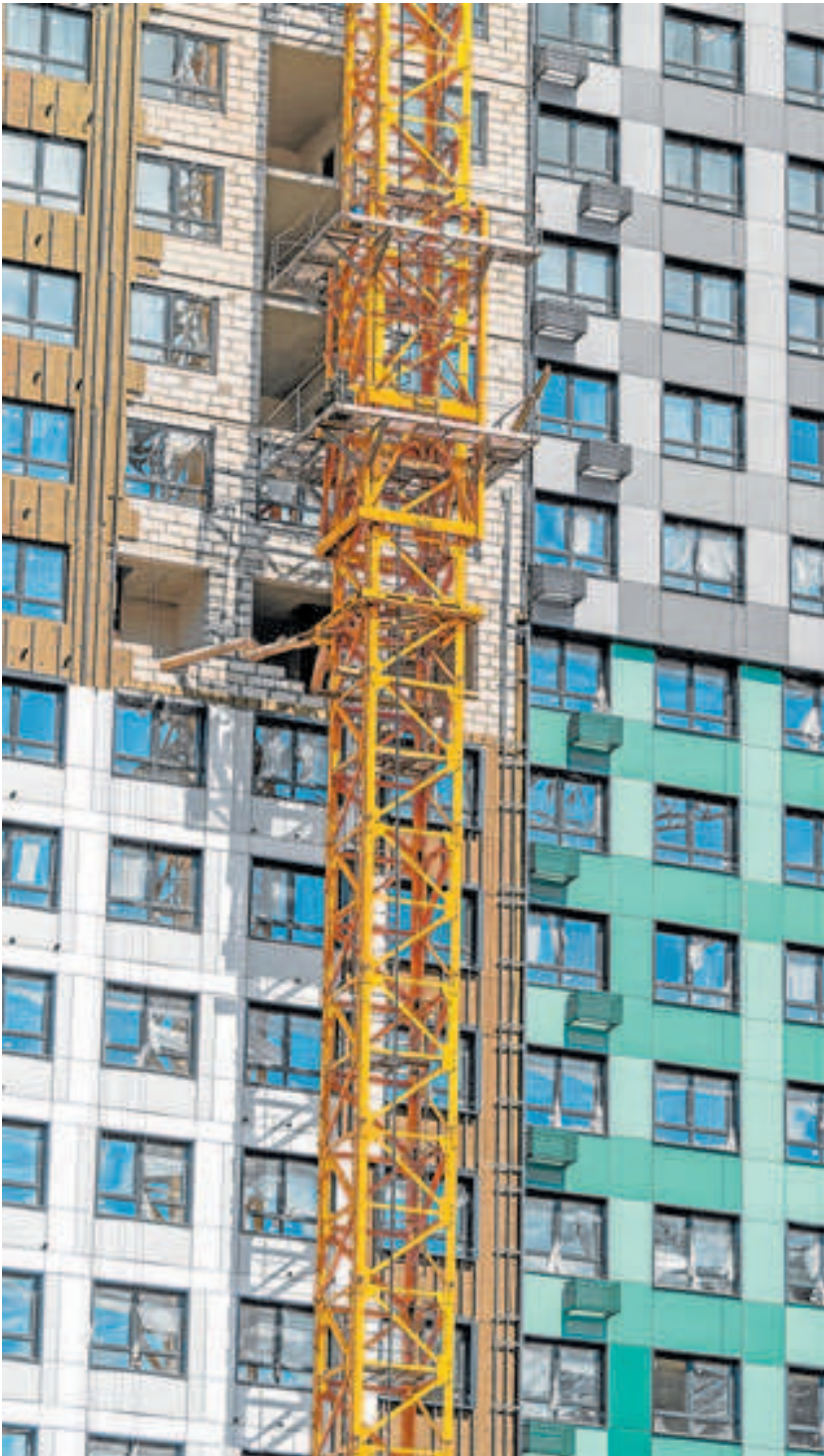
La rehabilitación energética potencia el confort y revaloriza el inmueble
