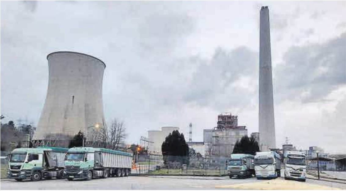
Imagen de archivo de la central de As Pontes.
