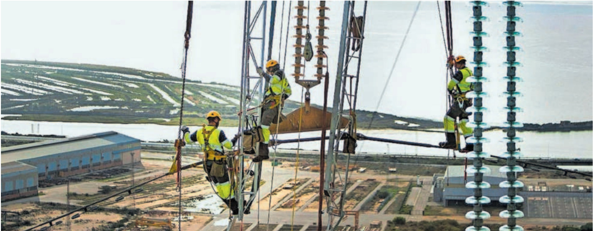
Trabajadores de Endesa en unas torres eléctricas de Cádiz, en una imagen facilitada por la empresa.
