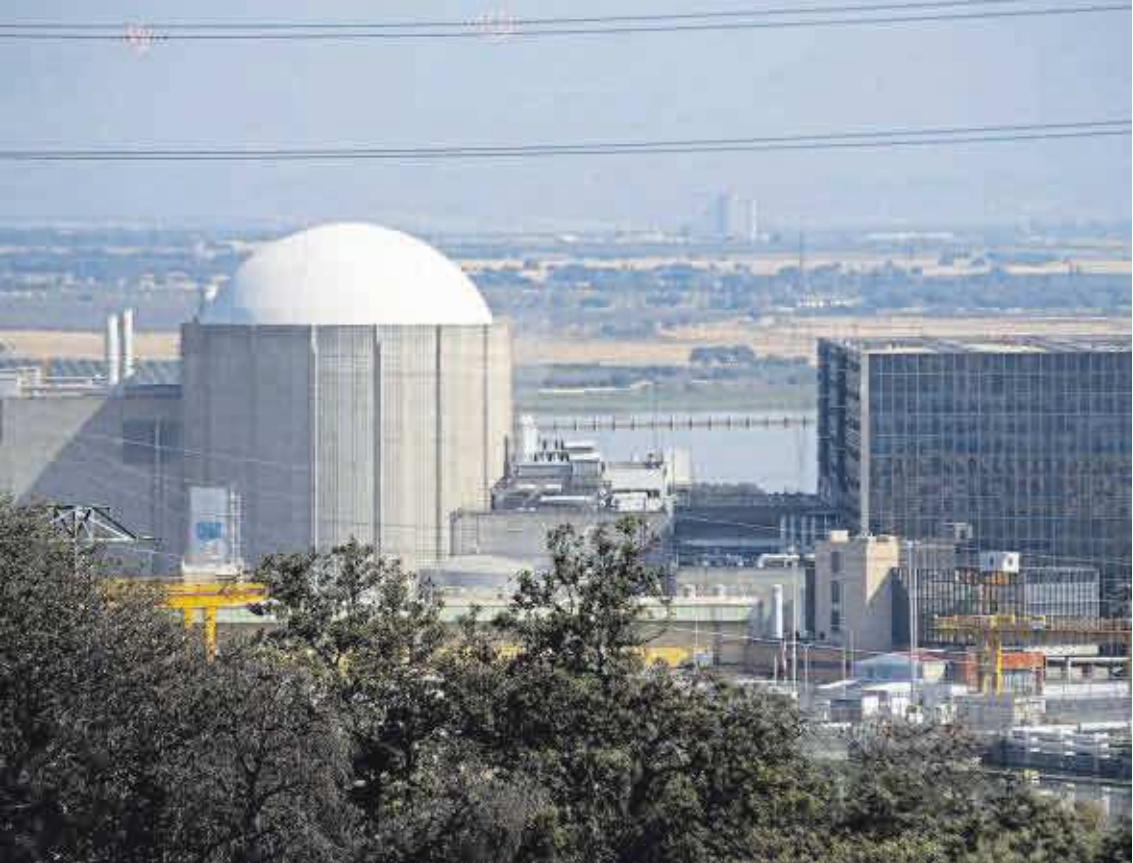
Panorámica de la Central Nuclear de Almaraz (Cáceres).
