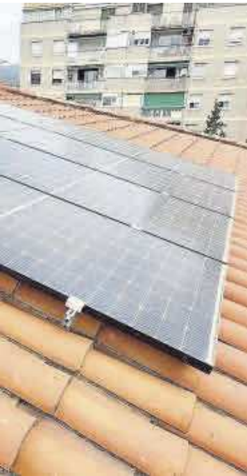
Placas solares en un edificio.
