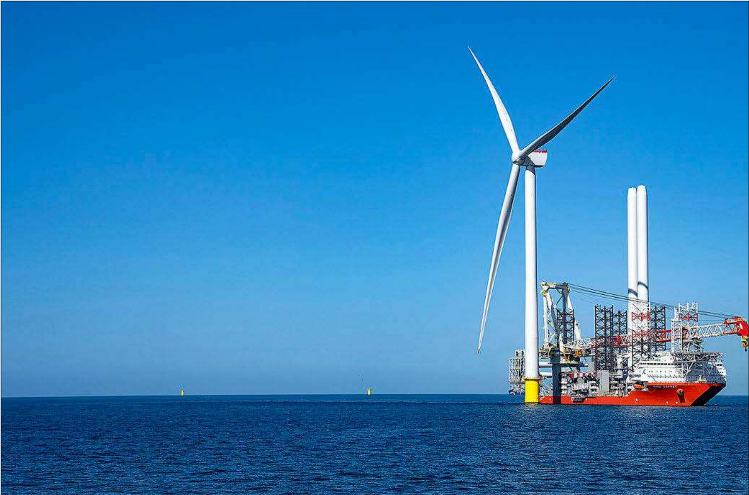
Primera turbina instalada en el parque eólico East Anglia THREE de ScottishPower y Masdar en mitad del agua, con palas de 115 metros. E.M
