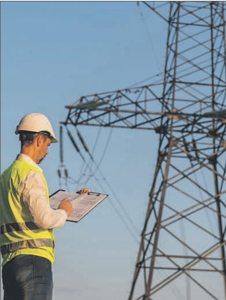
Un técnico inspecciona una torre de alta tensión. ISTOCK
