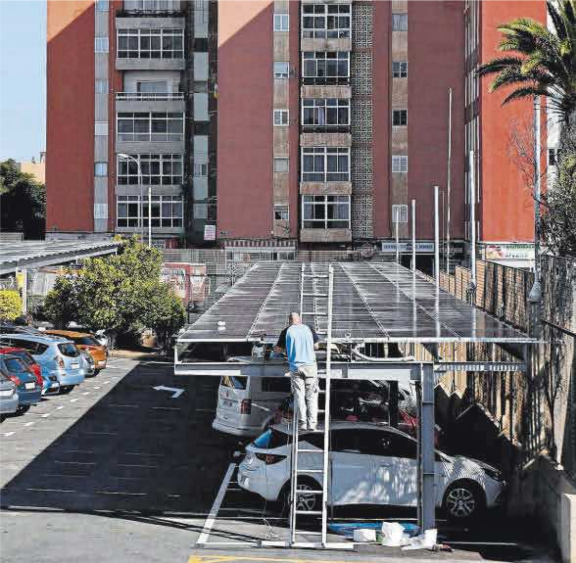
Instalación de paneles solares en un aparcamiento de una zona residencial de Las Palmas de Gran Canaria.
